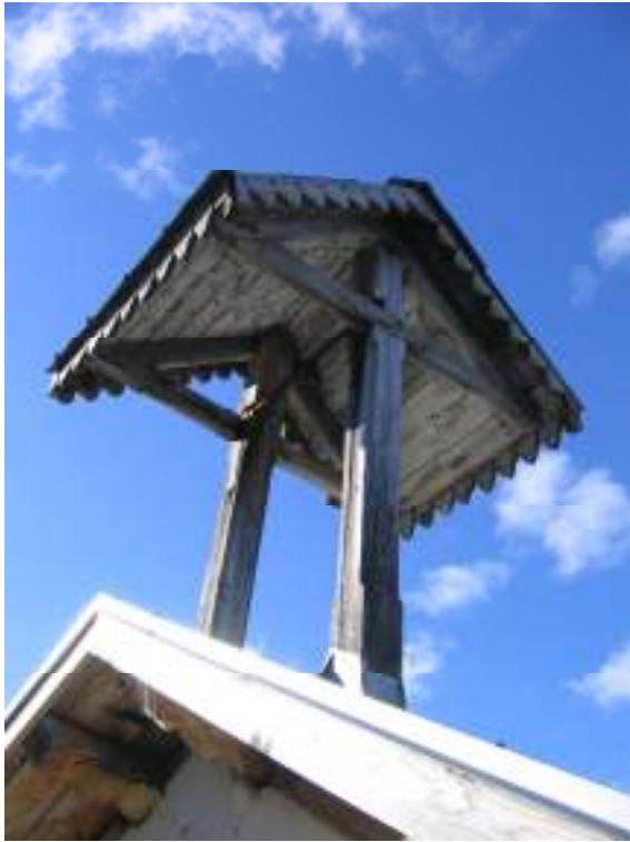
Klockstapel före åtgärder, år 2006.
