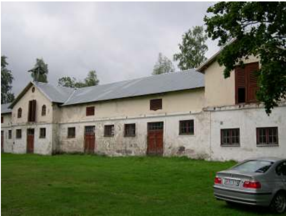
Västra och östra fasaderna före åtgärder, år 2005.
