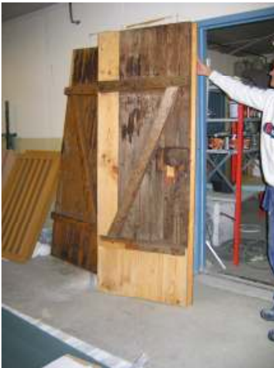
Insidan på en av dörrarna efter åtgärder, år 2006. Dörrarna målades endast på utsidan, lika befintligt utförande.
